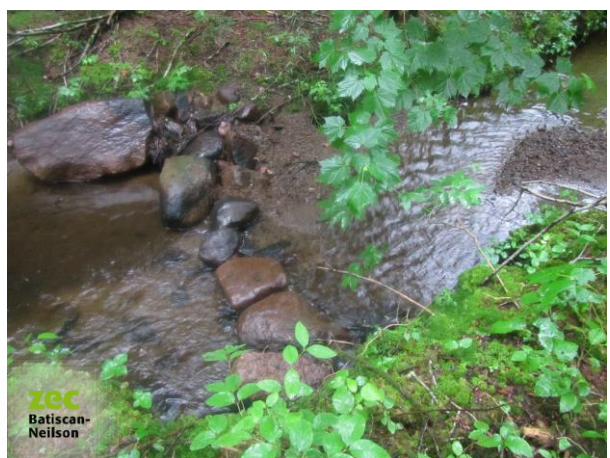
Figure 6. Site du seuil en roche au tributaire Gouts au lac Petit des Neiges avant l'entretien (vue de l'aval)
