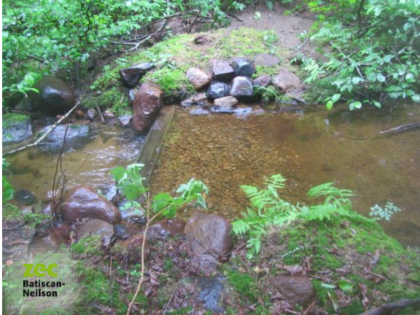
Figure 8. Site du seuil-frayère au mètre 729 au tributaire Gouts au lac Petit des Neiges après l'entretien (vue de côté)
