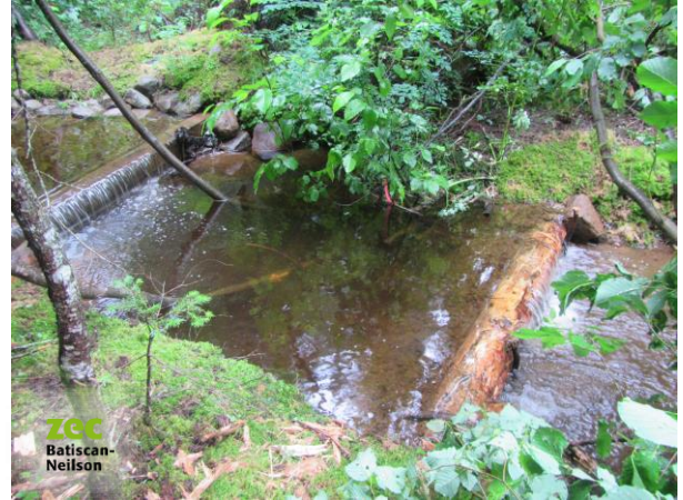
Figure 9. Seuil en bois au mètre 669 au tributaire Gouts au lac Petit des Neiges après l'entretien (vue de côté)
