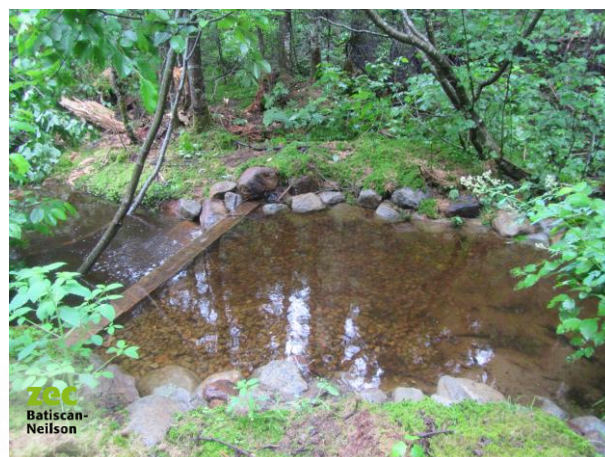
Figure 5. Site du seuil-frayère au mètre 673 au tributaire Gouts au lac Petit des Neiges après l'entretien (vue de côté)
