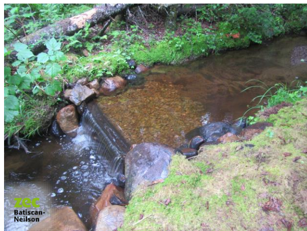
Figure 3. Site du seuil-frayère au mètre 716 au tributaire Gouts au lac Petit des Neiges après l'entretien (vue de côté)
